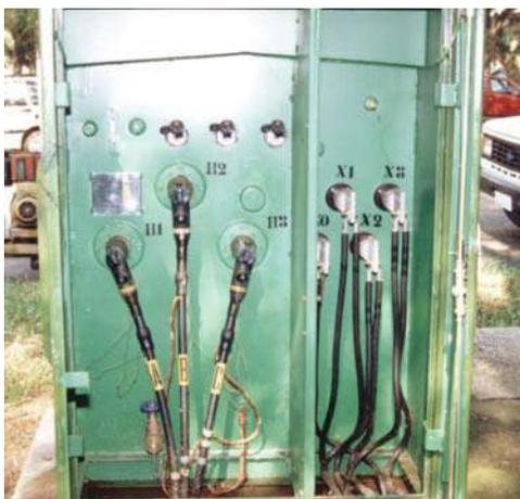
Figura 4.7 - Detalhe interno do transformador de 150 kVA.
