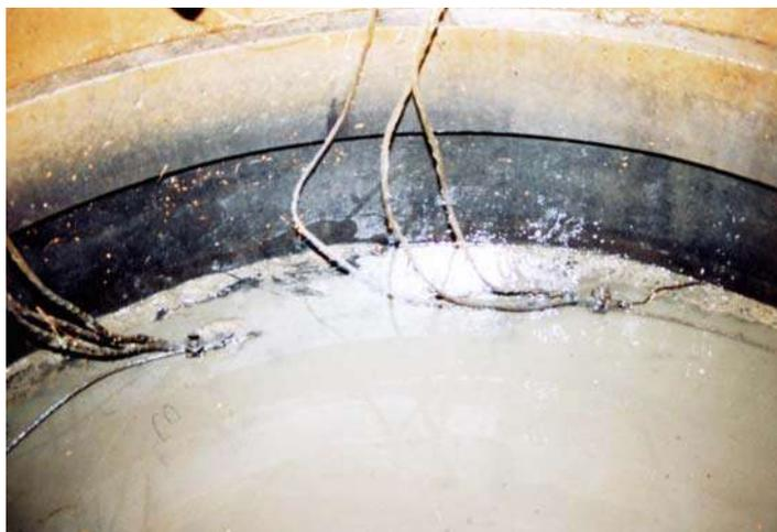
Figura 4.3 – Detalhe do aterramento na caixa de inspeção
