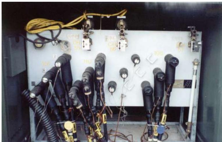
Figura 4.10 – Seccionador instalado em frente ao Hospital Universitário
