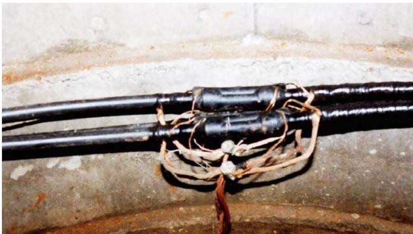
Figura 4.13 – Emenda dos cabos na caixa de inspeção n.º 25
