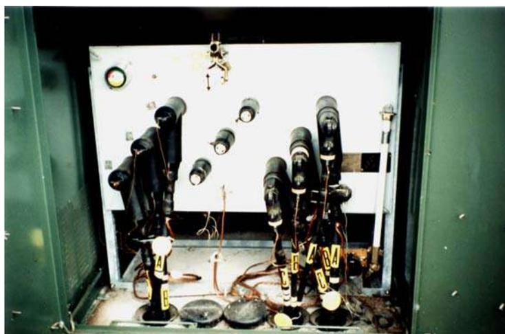
Figura 4.9- Detalhe do seccionador instalado próximo a Praça 4
